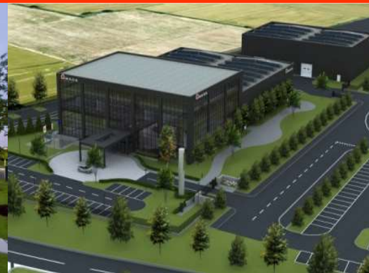
Technical Center Italien, Mailand
