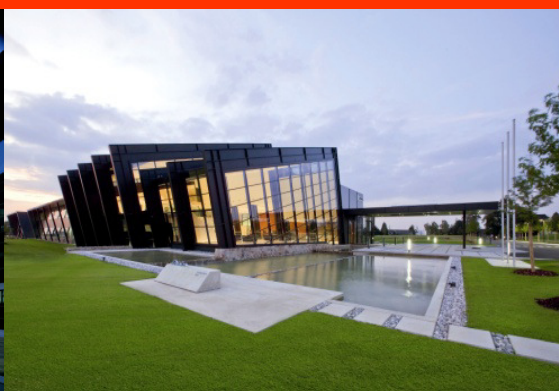
Europazentrale und Technical Center Deutschland, Haan
